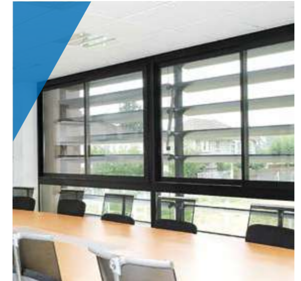
Lames de 300 mm motorisées - Inclinaison 15°
